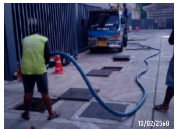
รูปที่ 2-20 การสูบล้างประตูลูกและกากไขมัน
