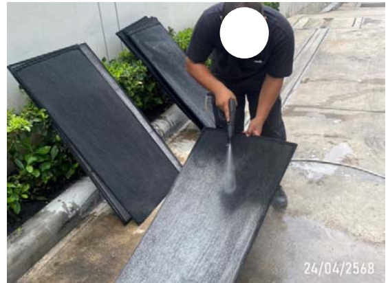
รูปที่ 2-40 การล้างทำความสะอาดเครื่องปรับอากาศ
