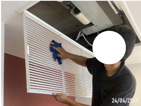
รูปที่ 2-40 การล้างทำความสะอาดเครื่องปรับอากาศ
