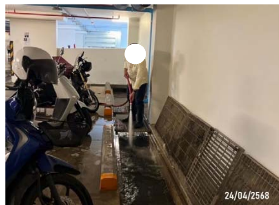
รูปที่ 2-25 การทำความสะอาดรางระบายน้ำ
