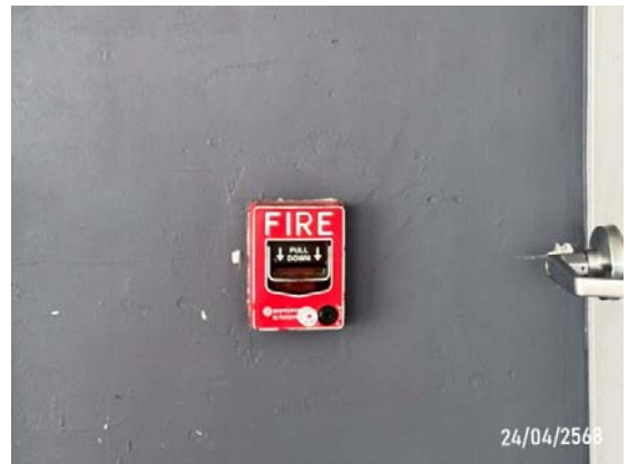
อุปกรณ์แจ้งเหตุด้วยมือแบบใช้มือดึง (Manual Pull Station)
