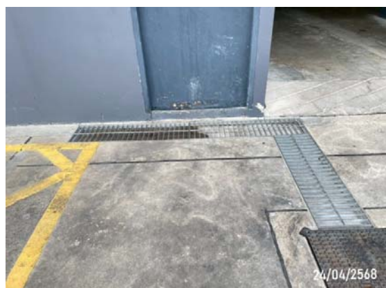
รูปที่ 2-33 รางระบายน้ำจากห้องพักมูลฝอยรวม
